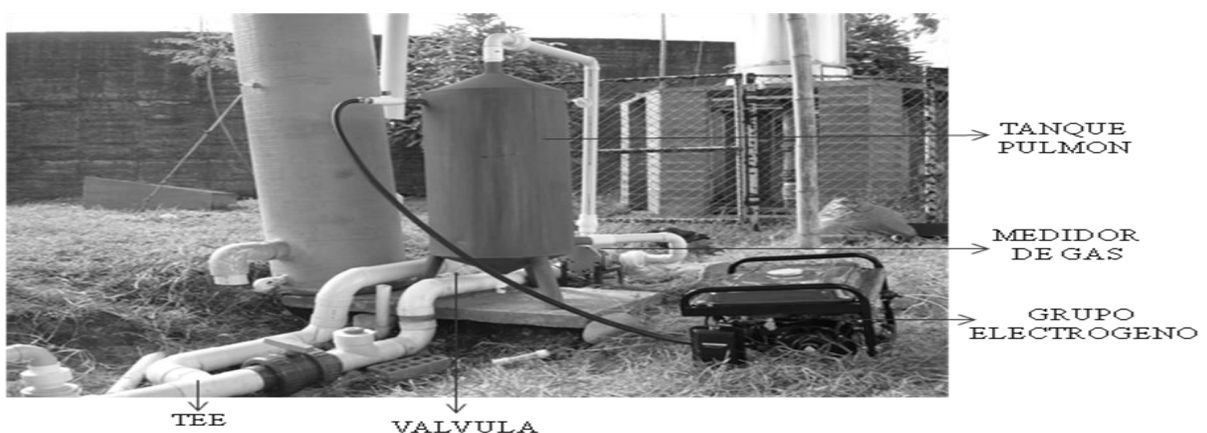
Figura 6. Adecuación de la línea de transporte de biogás.
