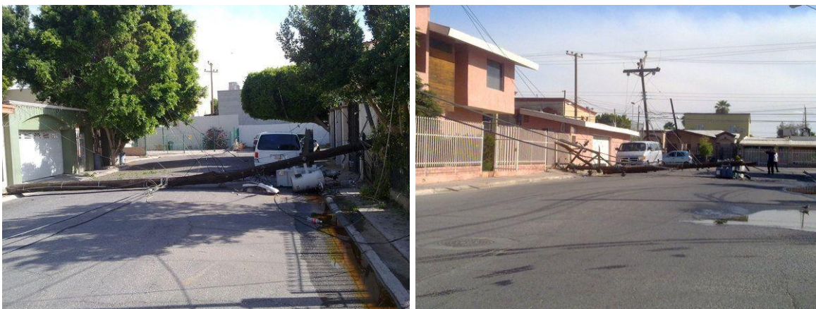
Figura 6. Afectaciones de la red de distribución de energía eléctrica en Mexicali.
