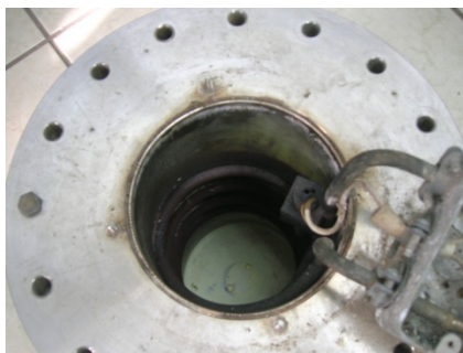
Ilustración 6 Resistencia eléctrica para aumento de temperatura
