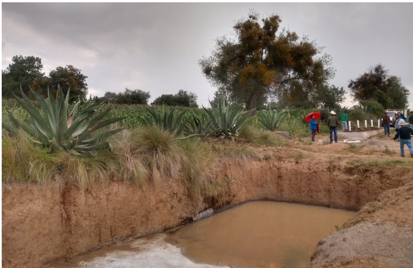
Figura 3. Obra de captación de agua pluvial en parcelas orgánicas de la Cuenca del Alto Atoyac, Tlaxcala. Fotografía de Mayrén Alavez Vargas.
